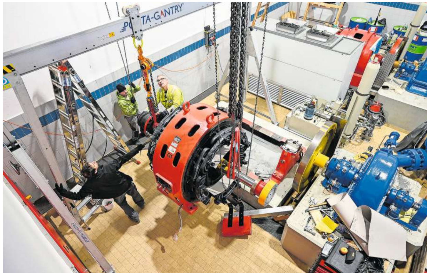
Der alte Generator im kloster-eigenen Wasserkraftwerk Tagenstal wird demontiert.
