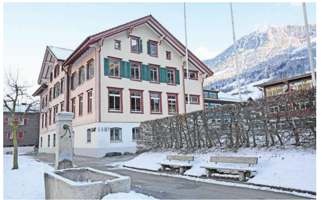
Der Altbau des Schulhauses Kamp stammt aus dem Jahr 1896. Bild: Robert Hess (Lungern, 7. Januar 2021)
